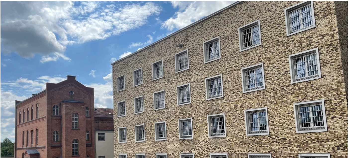
Außenansicht Justizvollzugsanstalt Berlin. Foto: © JVA Plötzensee
